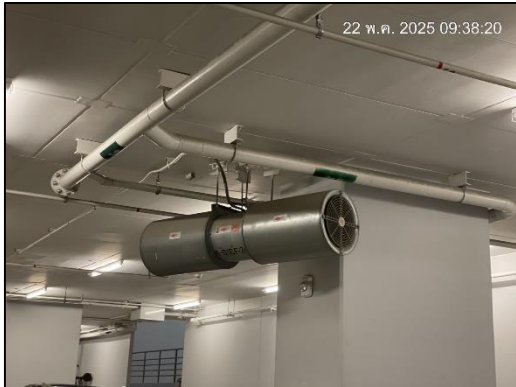
ภาพที่ 14 ระบบระบายอากาศ (Jet Fan)
